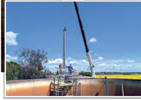
Der neue Trübwasserabzug wird installiert.
