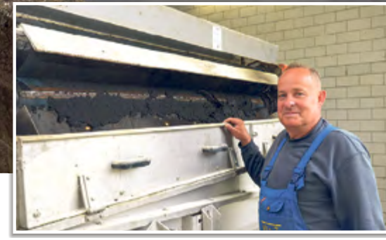
Die Schneckenpresse drückt einen Großteil des Wassers aus dem Schlamm.
