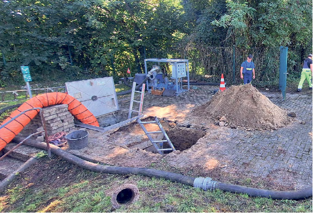
Um den Schacht sanieren zu können, musste er zunächst leergepumpt werden.
