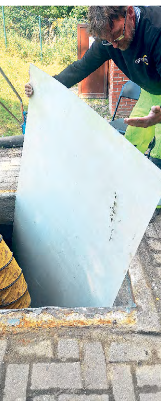
Die Wände des Schachts werden mit GFK-Platten ausgekleidet.
