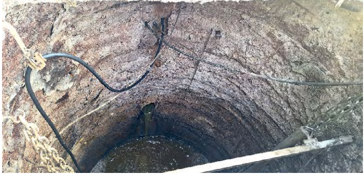
Das Schmutzwasser hat den Beton des Pumpschachts zerfressen.
