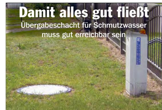
Bei Havarien leicht zu finden: der sichtbare Übergabeschacht für Schmutzwasser. Foto: SPREE-PR/Krone
