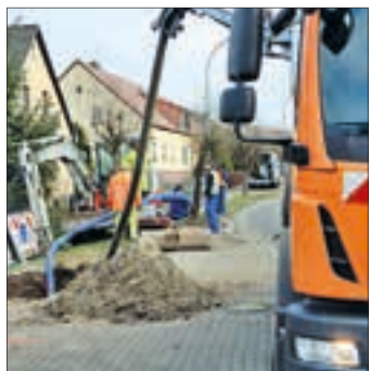
Rund um die Uhr arbeiten die Wasserwerker.
