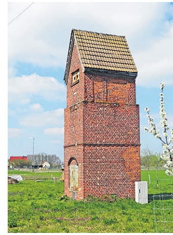
Früher Trafostation, heute eine der kleinsten Galerien der Welt.
